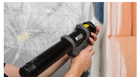
Auftrag als Sprühstrahl zum Abdichten von Details und Anschlüssen
