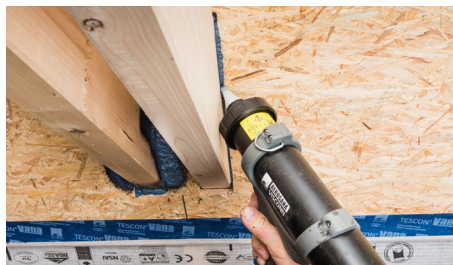
Auftrag als Raupe zum Schliessen von Fuge
