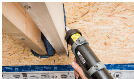
Application sous forme de cordon pour combler les joints Fuge
