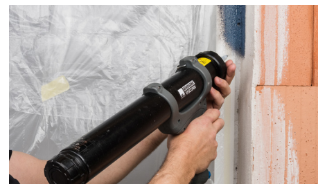
Application par jet de pulvérisation pour l'étanchéité Détails des points singuliers et des raccords
